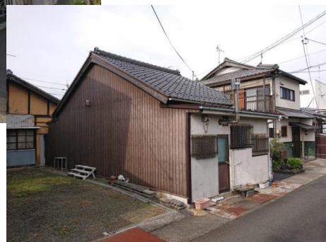
南東から見る
